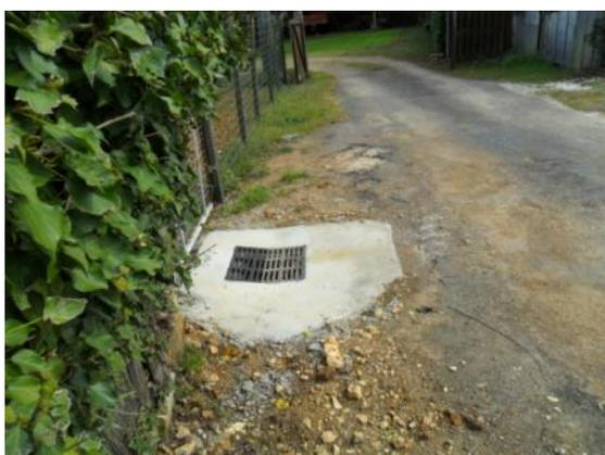
Travaux de busage sur la Coussardière pour améliorer l'écoulement des eaux pluviales
